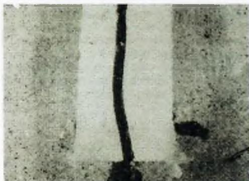
c. Les gouttières sont ensuite remplies avec un mortier de résine époxy et les fissures sont soigneusement bouchées avec un produit pour joints
