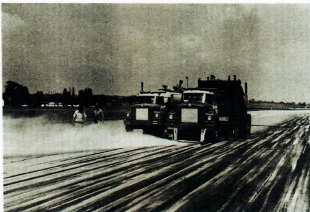
Figure III.2.3 – Enlèvements du caoutchouc au moyen de jets d'eau à haute pression
