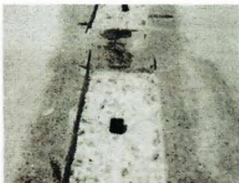
a. Une gouttière est creusée à la surface de la chaussée le long de la fissure
