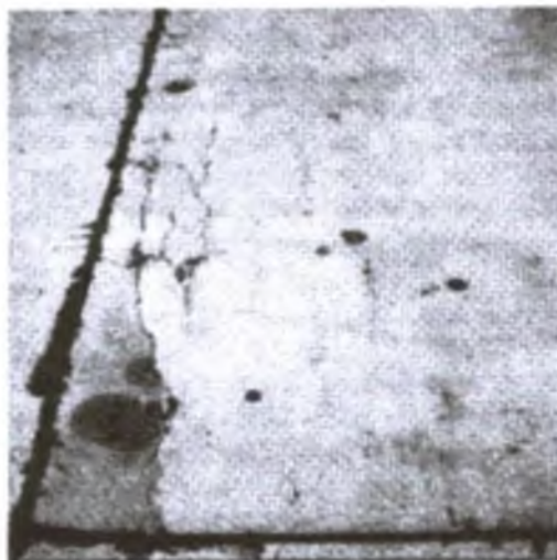
a. Fissures à la surface d'une dalle de béton
