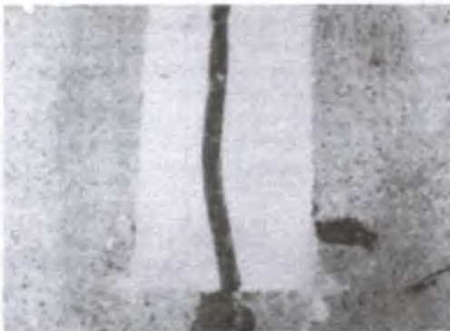
Figure III.2-2.- Réparation d'une fissure profonde dans une chaussée en béton
