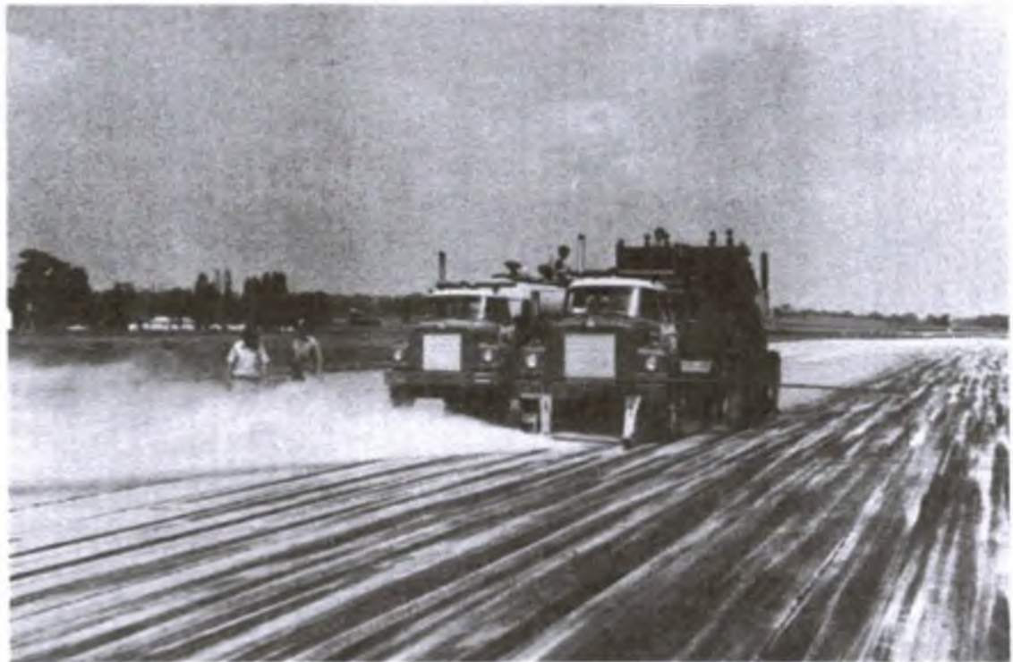
Figure III.2.3 – Enlèvements du caoutchouc au moyen de jets d'eau à haute pression
